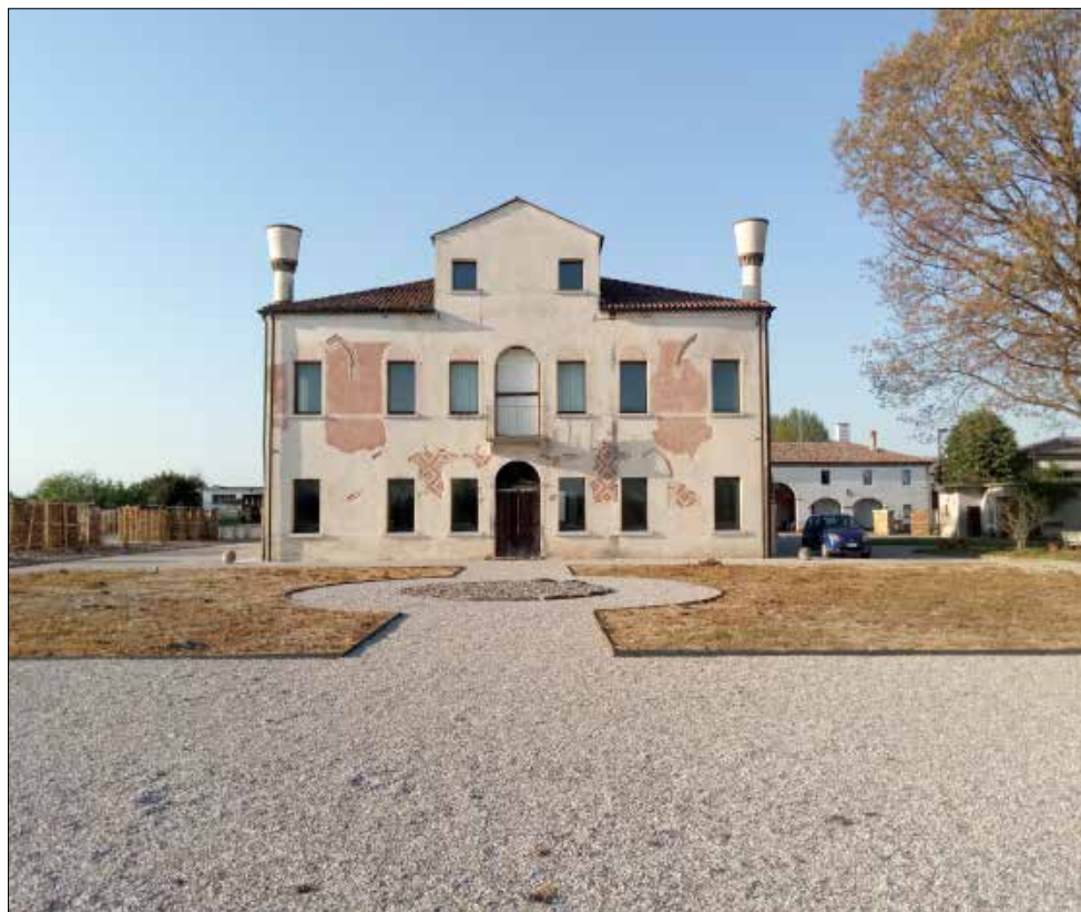
Figura 5: Foto villa Moro Bernardo a Peseggia (VE). Come si può osservare i due camini caratterizzano architettonicamente la villa e sono messi in rilievo nella rappresentazione fornita dal disegno.
