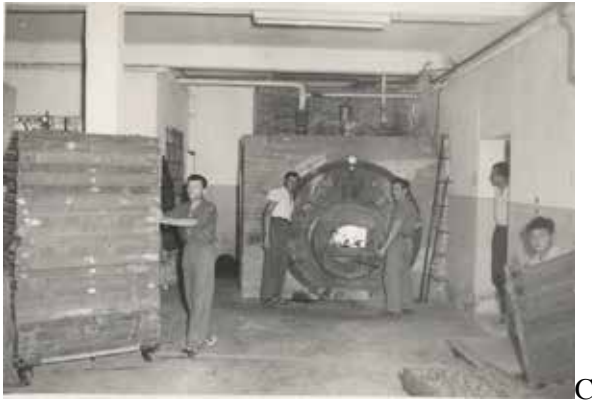
Caldaia a vapore ed essiccatoio [Foto Famiglia Pietro Berton]
