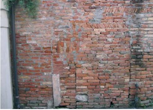
13. Parete in mattoni in via la Bova a Noale dalla complessa stratigrafia. Si evidenziano diverse tecniche di posa tra cui parte di un arco ribassato. Curiose sono le due file di tavelle, probabilmente di materiale di recupero, disposte oblique in modo da facilitarne la posa.
