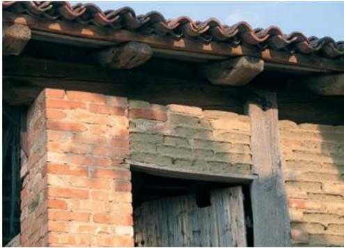
7. Esempio di muratura in *adobe*. Questa diversa tecnica può essere dovuta a una precisa scelta costruttiva o alle diminuite possibilità economiche di chi ha realizzato il tamponamento su un edificio esistente.
