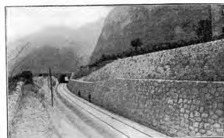
Galleria di Val Gallena.
