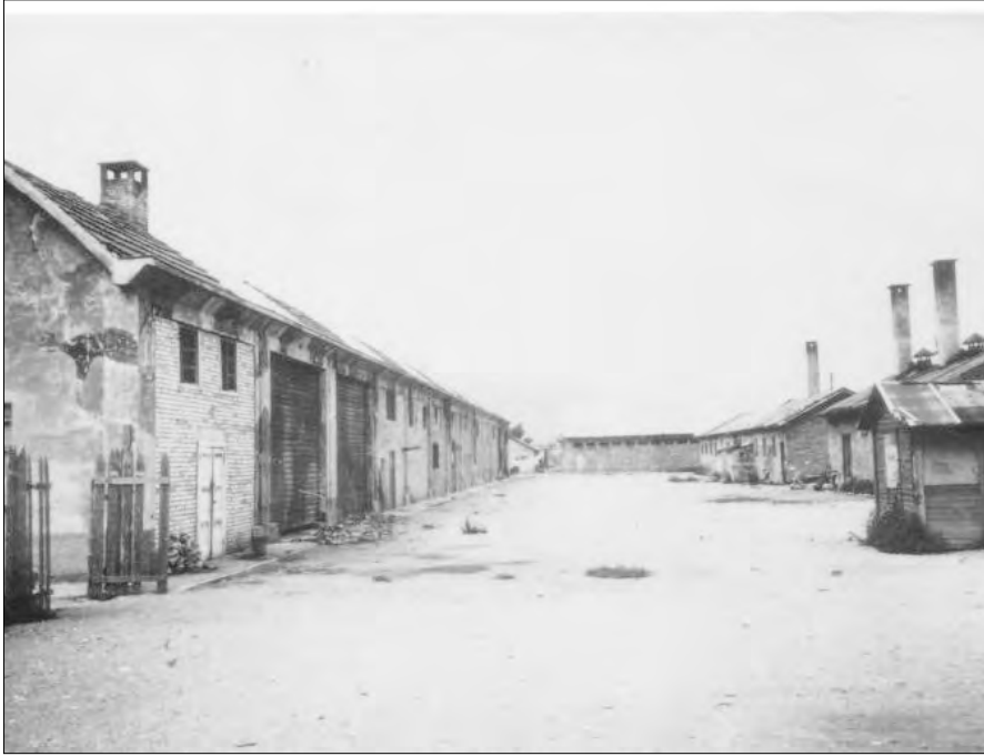
Blocchi lato sud lager di Bolzano
