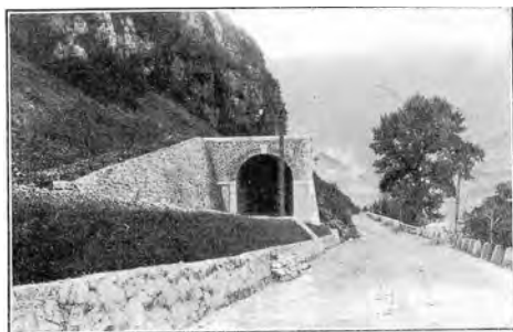
Galleria Sambugo, imbocco Nord.
