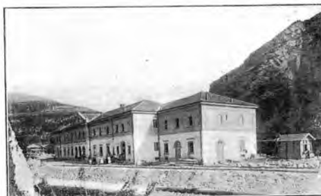
Facciata esterna della stazione di confine a Primolano.
