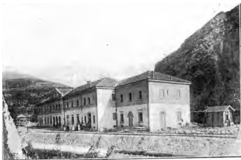
Facciata esterna della stazione di confine a Primolano.
