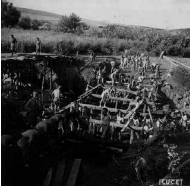
Pontieri al lavoro nel 1941 per la costruzione del ponte a Dniepropetrowsk
