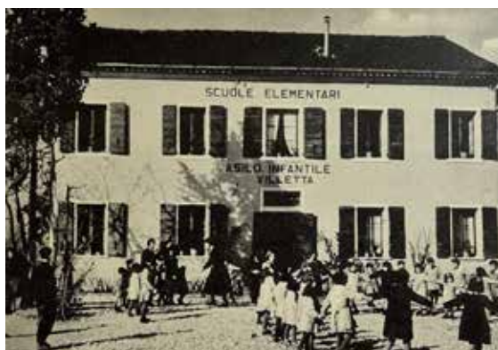
Scuola elementare - Asilo infantile, Villetta di Salzano
